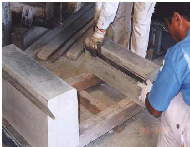
防草ブロック 型枠引き抜き中
