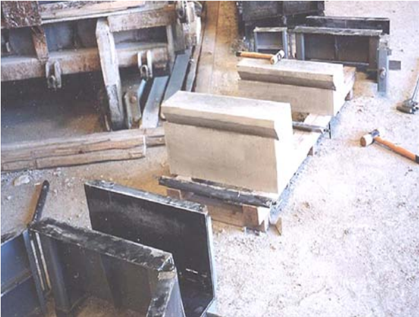
防草ブロック 型枠と試作品
